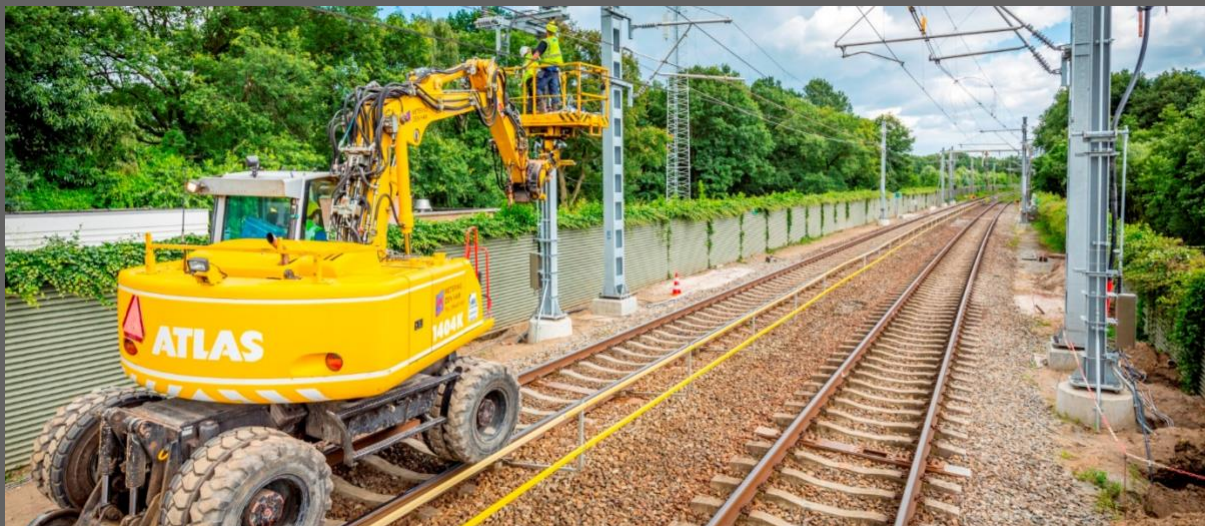
Overhead Lines – Foto: Jorrit Lousberg - Bron: Dura Vermeer
