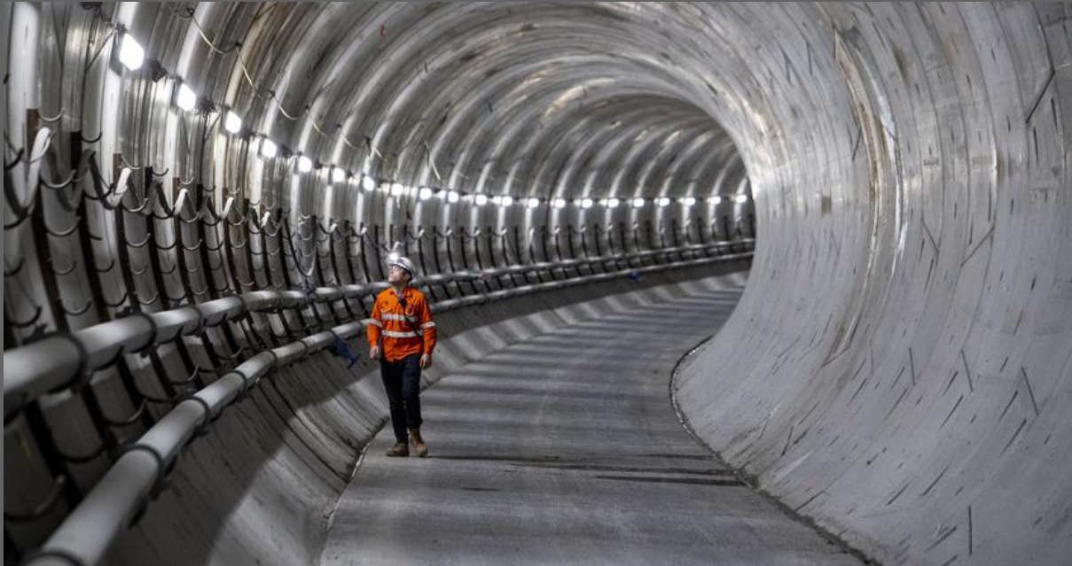
In de tunnels bij Waterloo Station. Bron: https://sydneymetro.info/
