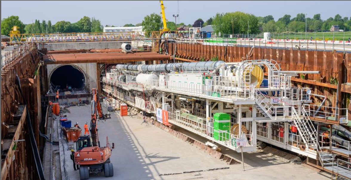
Tunnelboormachine in de startschacht bij aanvang - Foto: Rick Keus - Bron: https://rijnlandroute.nl/
