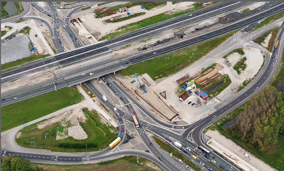
Viaduct A44 bij knooppunt Leiden-West – Foto: Roelof de Vries - Bron: https://rijnlandroute.nl/
